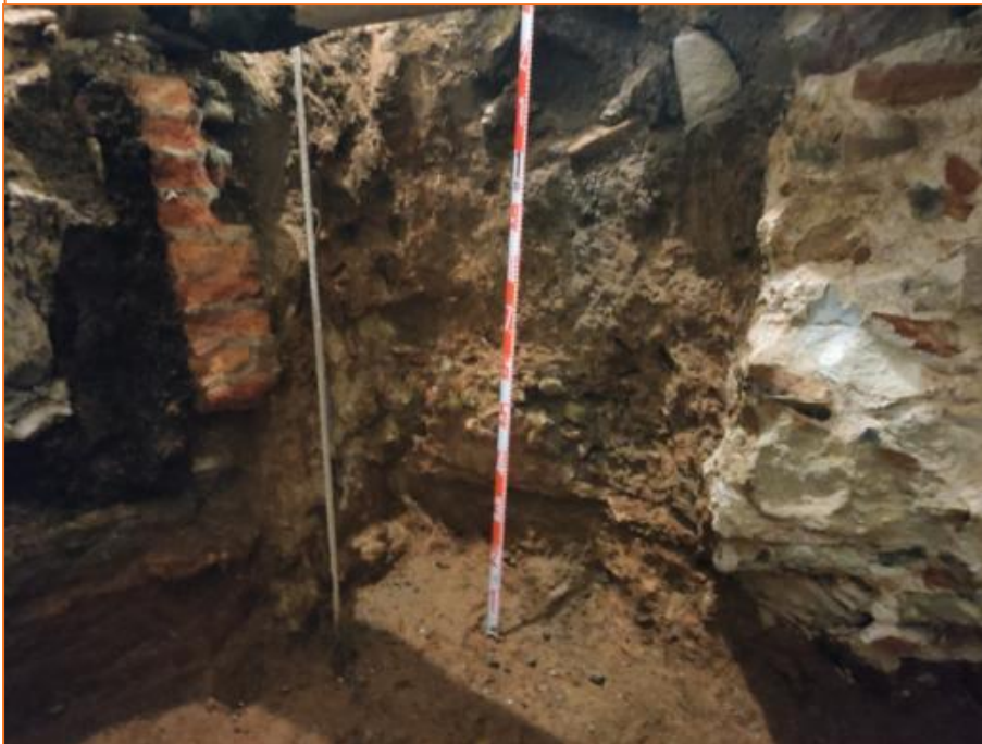
Foto 9. Vista de detall en secció del mur UE 8, així com dels estrats UE 11 i UE 12.
