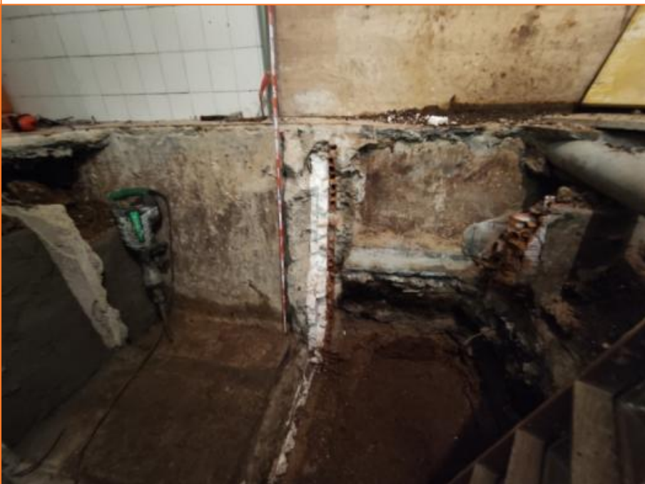
Foto 6. Vista del perfil est del rebaix amb els dipòsits UE 3 i UE 4.
