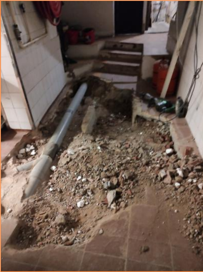
Foto 1. Vista inicial del rebaix del fossat d'ascensor.
