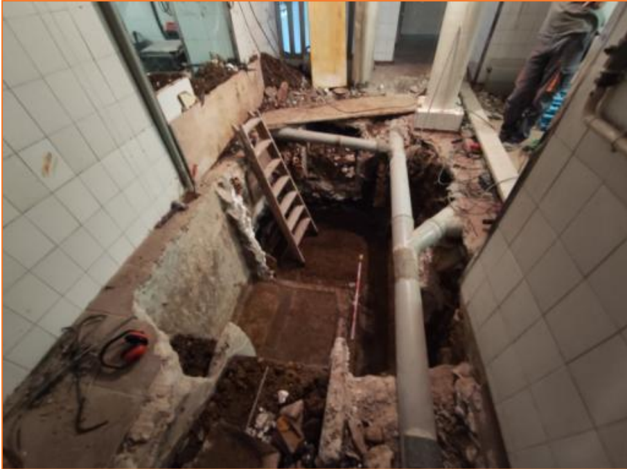
Foto 13. Vista final del rebaix des del nord.
