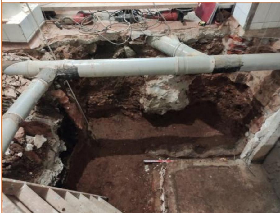
Foto 12. Vista final del rebaix des de l'est.
